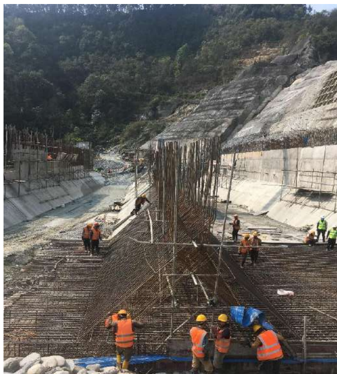
तस्विर २१: सेती खोला जलविद्युत आयोजना (२२ मेगावाट) को हेडवर्क्स संरक्षण र डिसान्डर बेसिनको निर्माण कार्य हुँदै
