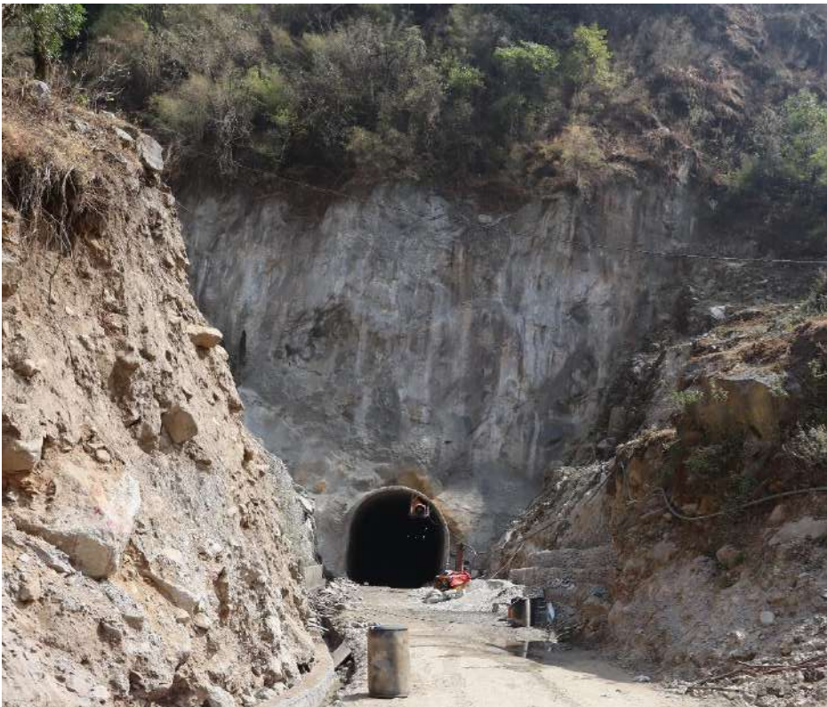
तस्विर १८: रोल्वालिङ खोला जलविद्युत आयोजनाको विद्युत उत्पादन गृहको सुरङ निर्माण
